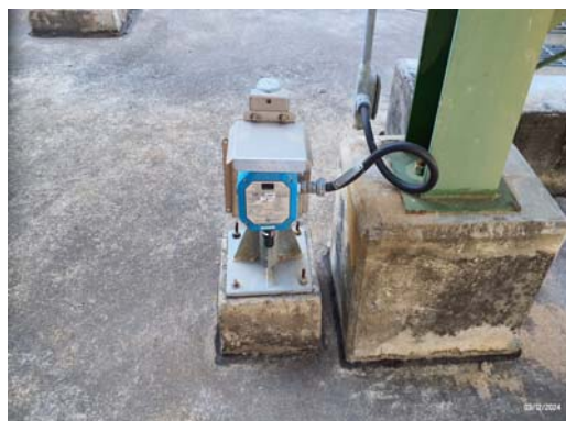
รูปที่ 3.2-49 Gas Detector
