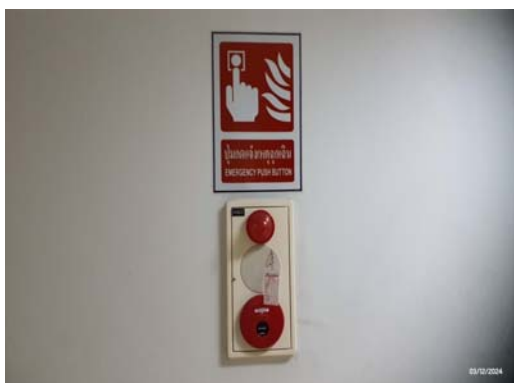
รูปที่ 3.2-50 ระบบตรวจจับและแจ้งเตือนไฟไหม้
