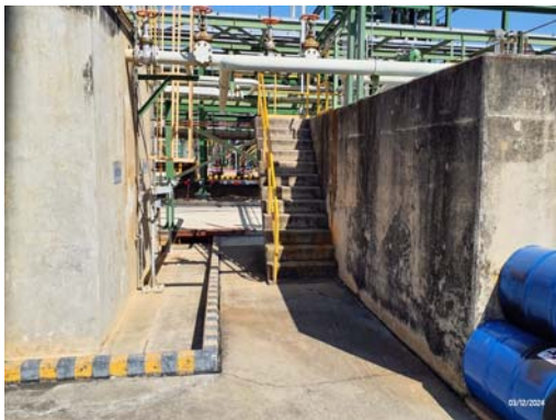
รูปที่ 3.2-19 พื้นที่คอนกรีตที่ลาดเอียง เข้าหาบ่อดักน้ำ (Catch Basin)
