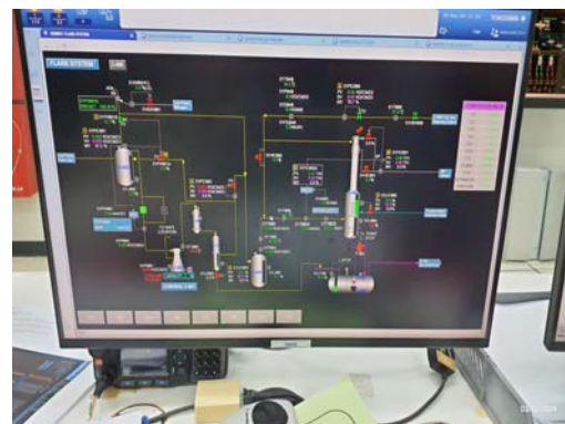
รูปที่ 3.2-3 ระบบควบคุมหอเผา
