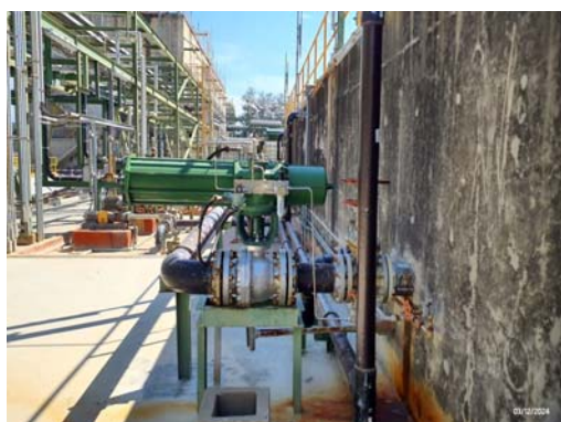
รูปที่ 3.2-8 Control Valve
