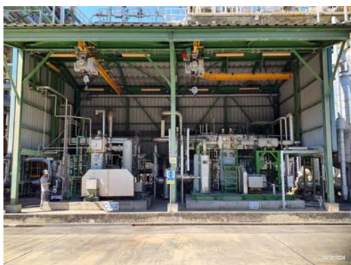
รูปที่ 3.2-4 Flash Gas Compressor (C-222)
