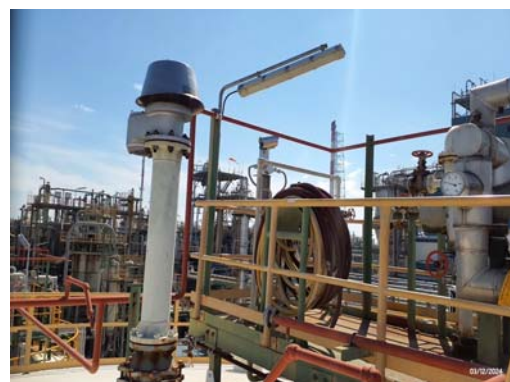
รูปที่ 3.2-5 ระบบท่อรวบรวม Vent Gas
