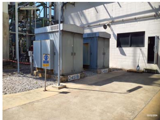
รูปที่ 3.2-22 อุปกรณ์ลดระดับเสียง (Sound Enclosure Cover Equipment)
