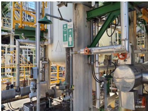
รูปที่ 3.2-38 จุดชำระล้างร่างกาย และล้างตาฉุกเฉิน
